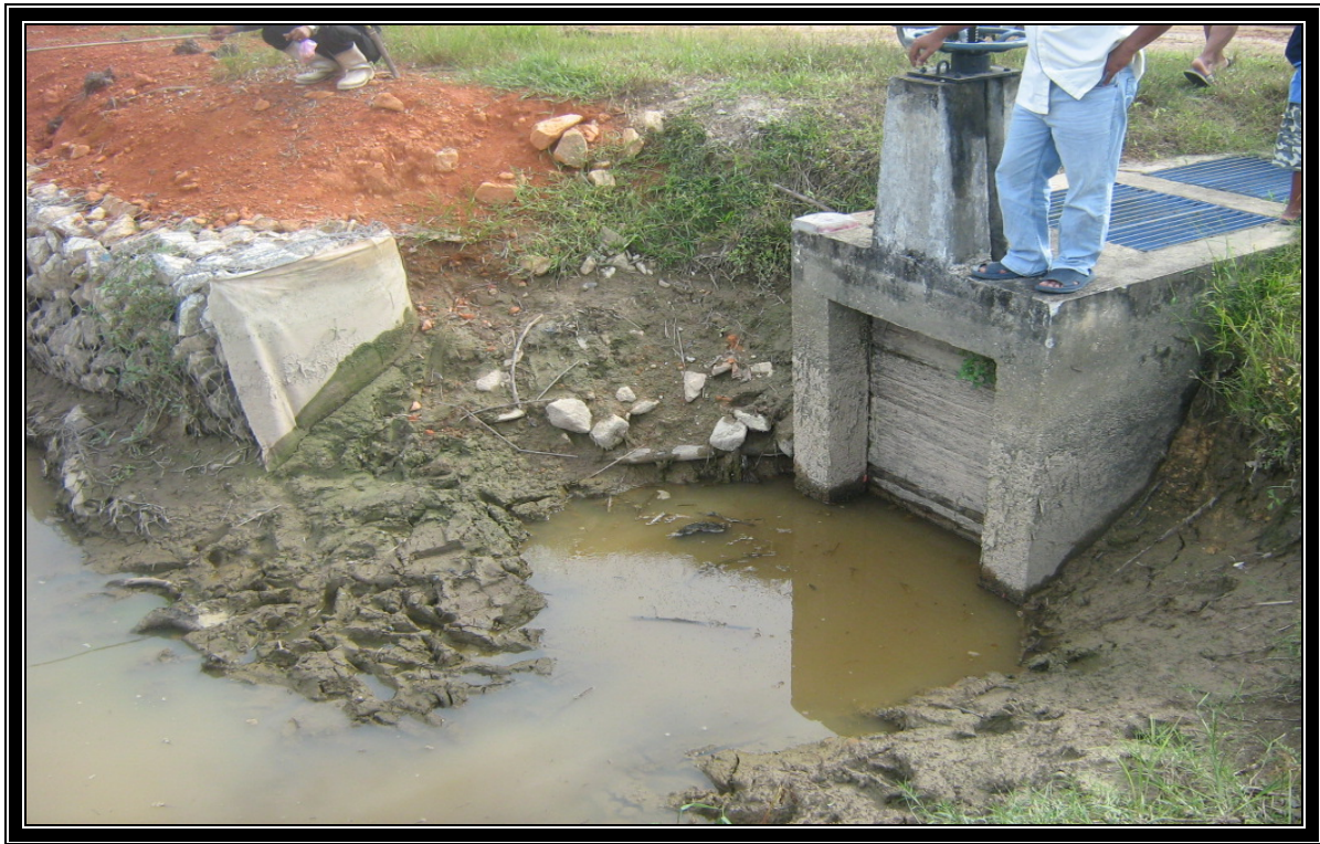
LONGGOKAN PASIR DI HADAPAN PINTU AIR CHO
