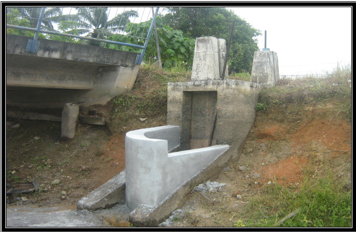
'KOTAK KAUSAR' YANG TELAH SIAP DI BINA
