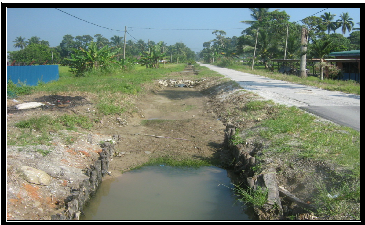
MENDAPAN PASIR DALAM TALIAIR TERSIER
