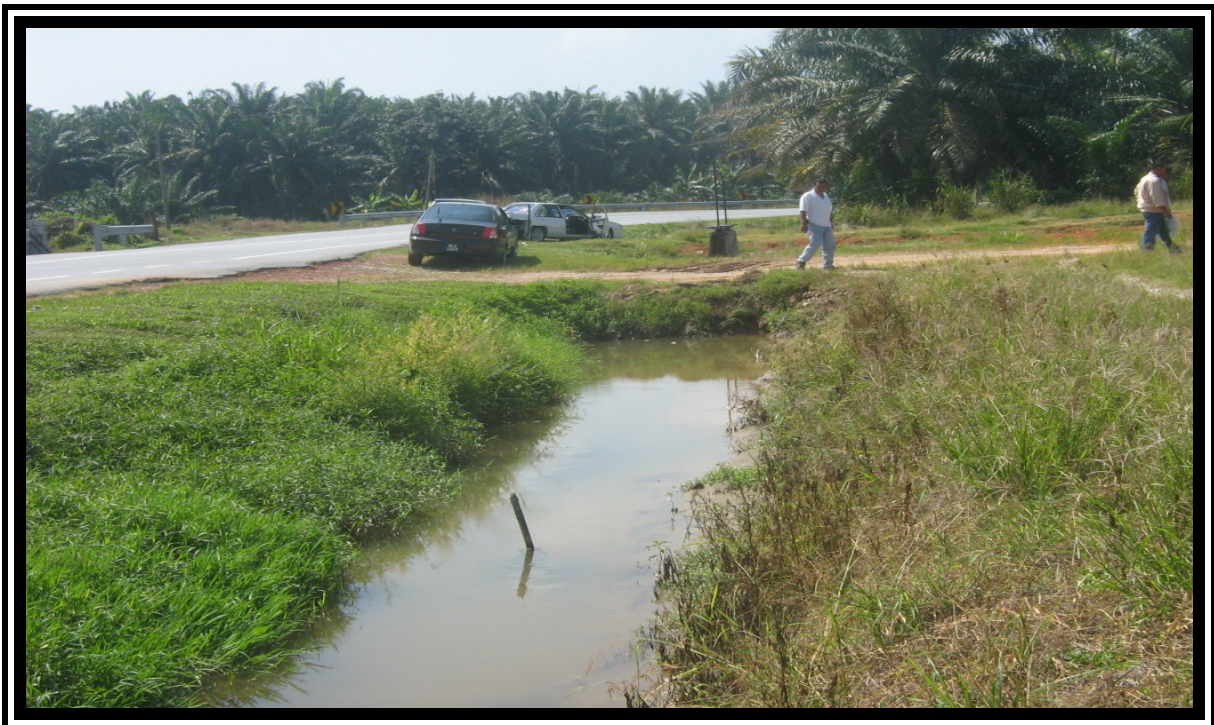
TALIAIR TERSIER BEBAS DARI LONGGOKAN DAN MENDAPAN PASIR
